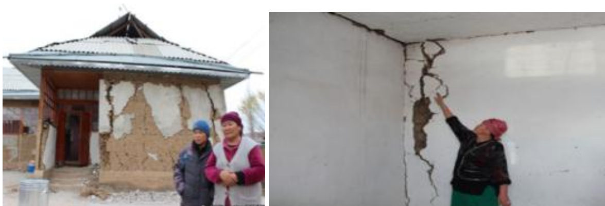
Рис.2. Состояние домов после землетрясения в Кара-сууйском районе 2015 г.
