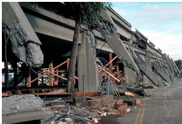
Рис. 4. Разрушение колонн виадука в Сан-Франциско во время землетрясения в октябре 1989 г.
