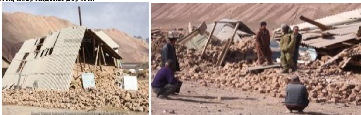
Рис.1. Состояние домов после землетрясения в с. Нура 2008 г.
